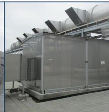
空調箱機房頂部
