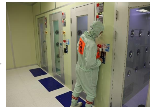
進入空氣淋浴室 ( Air Shower ) 前刷卡二次驗證
